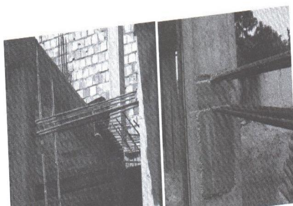
شکل ۴- روش تیر میان طبقه به ضخامت دال
