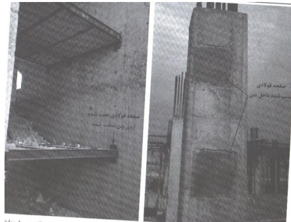
شکل ۶- روش تیر میان طبقه فولادی
