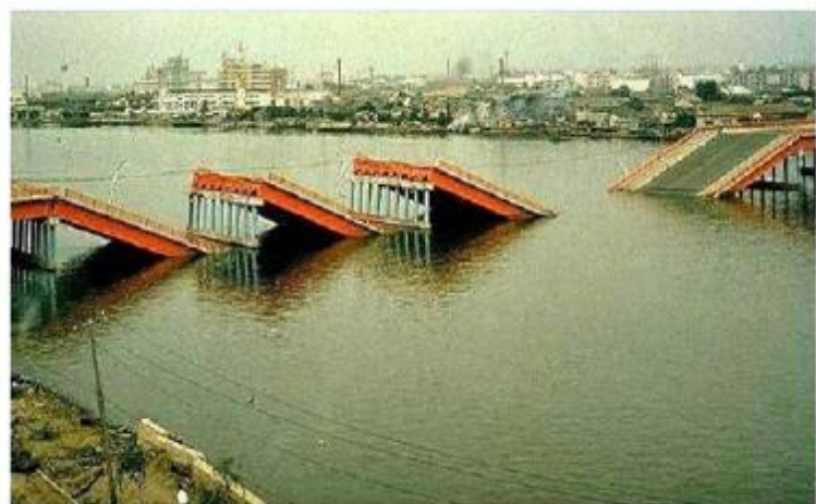
شکل ۱-۷- خرابی پل Showa در اثر روانگرایی در زلزله نیکاتا
