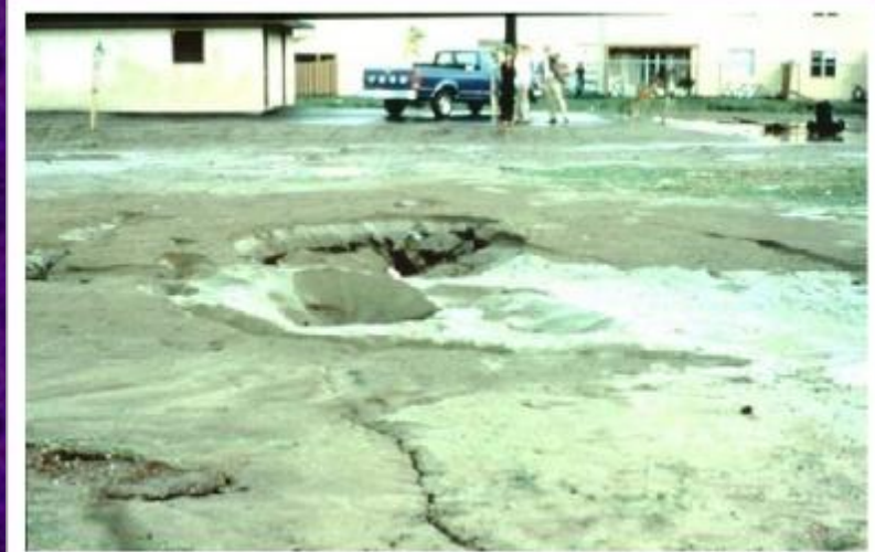
شکل ۱-۱۱- ترک‌خوردگی زمین و جوشش ماسه در جزیره Treasure در زلزله Loma Prieta
