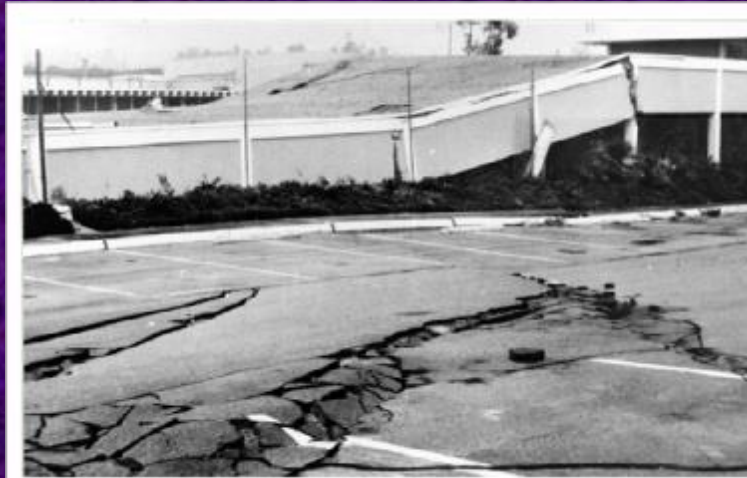
شکل ۱-۹- تغییر مکان زمین ناشی از گسترش جانبی در منطقه Juvenile Hall در طی زلزله ernando
