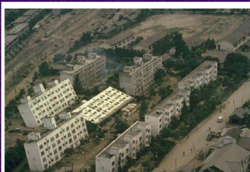
شکل ۱-۵- خرابی آپارتمان‌های Kawagishi-Cho در اثر روانگرایی در زلزله‌ی نیکانا
