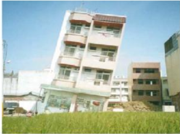
شکل ۱-۱۵- گسیختگی پی در اثر روانگرایی در شهر Yuanlin در زلزله‌ی Chi Chi
