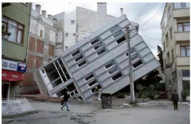
شکل ۱-۱۳- نمونه‌ای از کج‌شدگی و تخریب ساختمان‌ها در شهر Adapazari در زلزله Kocaeli
