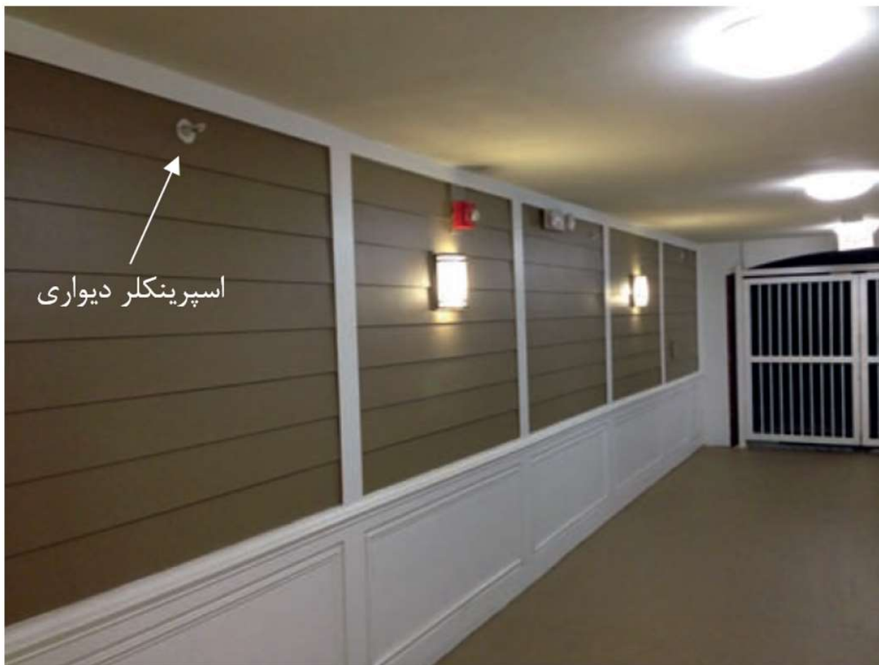
شکل ۹-۲۷ نصب اسپرینکلر دیواری بر روی دیوار راهرو
