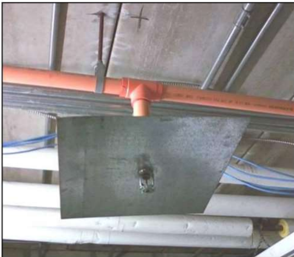
شکل ۲۶-۱۳ روش نادرست برای کمک به فعال شدن اسپرینکلر
